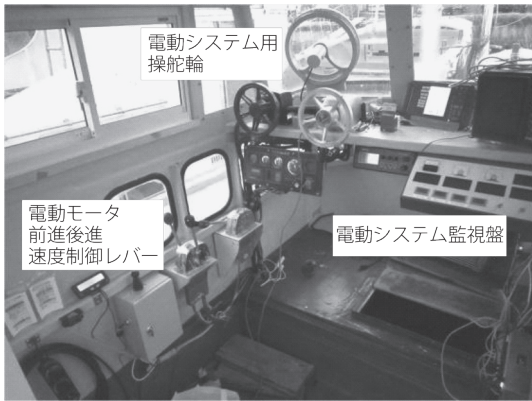
図 12：PHEB-2の操舵室写真
