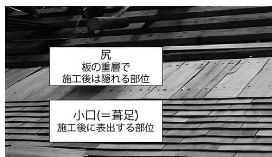
図2：スギ製こけら板の小口と尻(重要文化財 長國寺真田信之靈屋宝殿こけら葺解体修理現場・長野県松代市)
